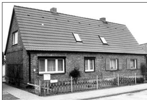
Abb. 3a: Zweifamilienhaus Ravensburgstraße
