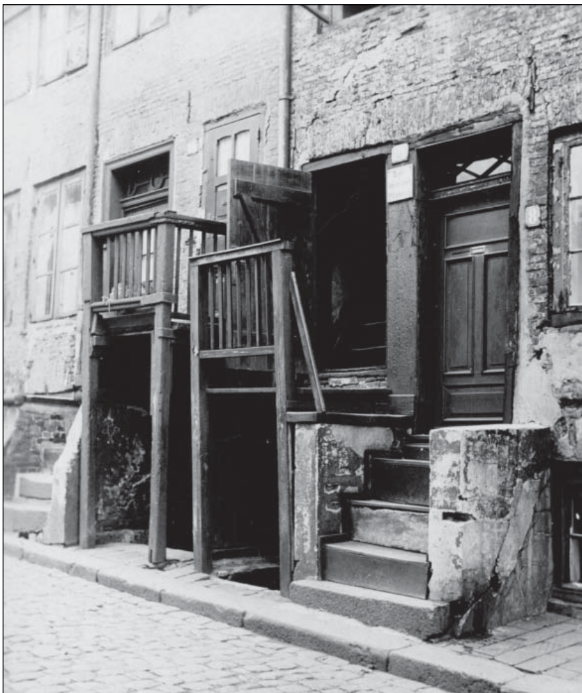
Die Eingangsbereiche zu diesen beiden Häusern in der Großen Schmiedestraße liegen direkt am Straßenpflaster und zeigen typische Wohnungseingänge des frühen 19. Jahrhunderts in der Altonaer Altstadt. Zwei führen in Kellerwohnungen, die anderen in die Buden- und Sahlwohnungen, wie die Erdgeschoss- und Etagenwohnungen in diesen Häusern genannt wurden. Foto von 1930
