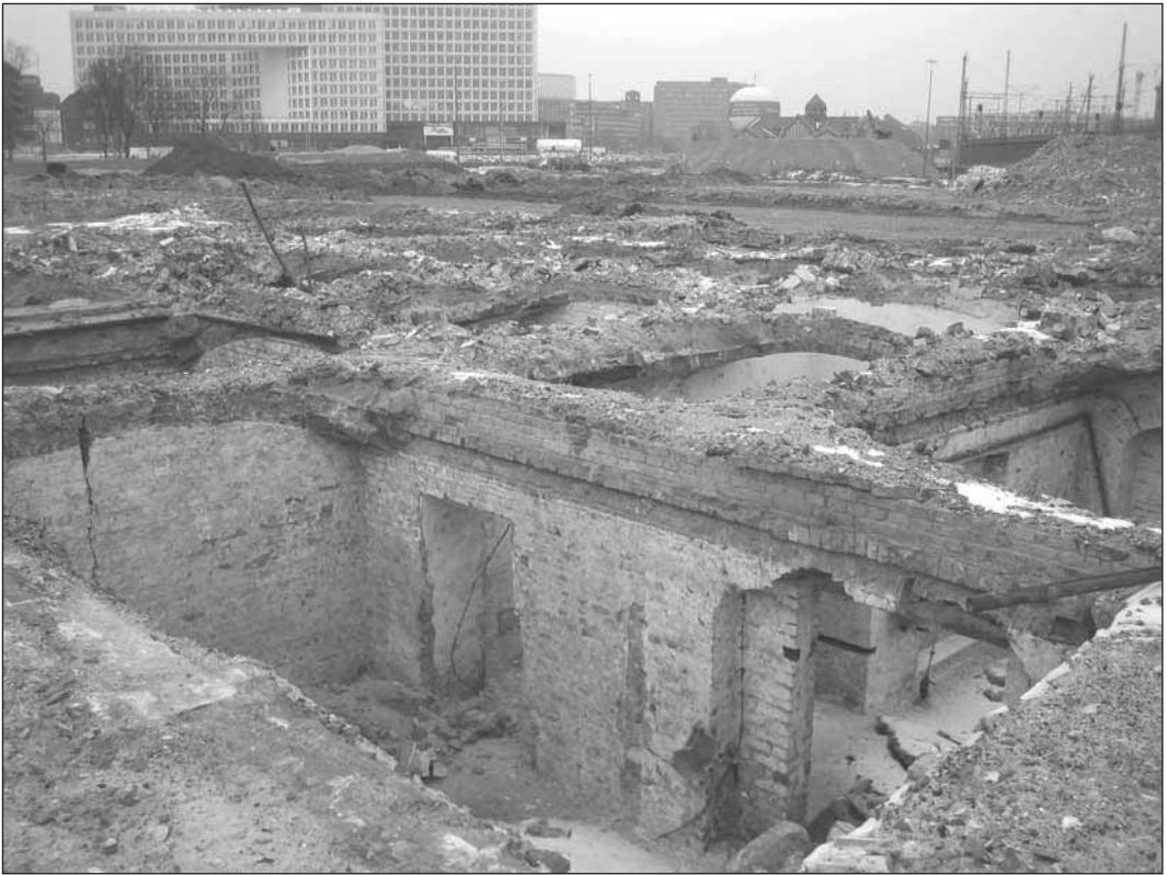
Unterirdische Gebäudereste des Hannoverschen Bahnhofs Anfang 2014
