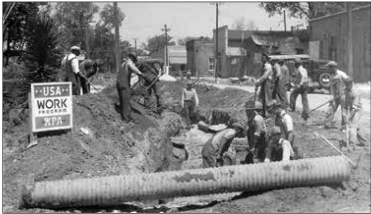
Eine von tausenden Infrastrukturarbeiten der Works Progress Administration. Alabama, im April 1934.
