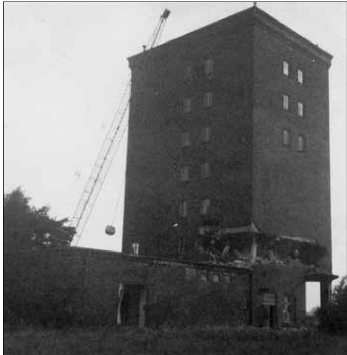
Der Kohlenbunker beim Abbruch (Foto: HEW)
