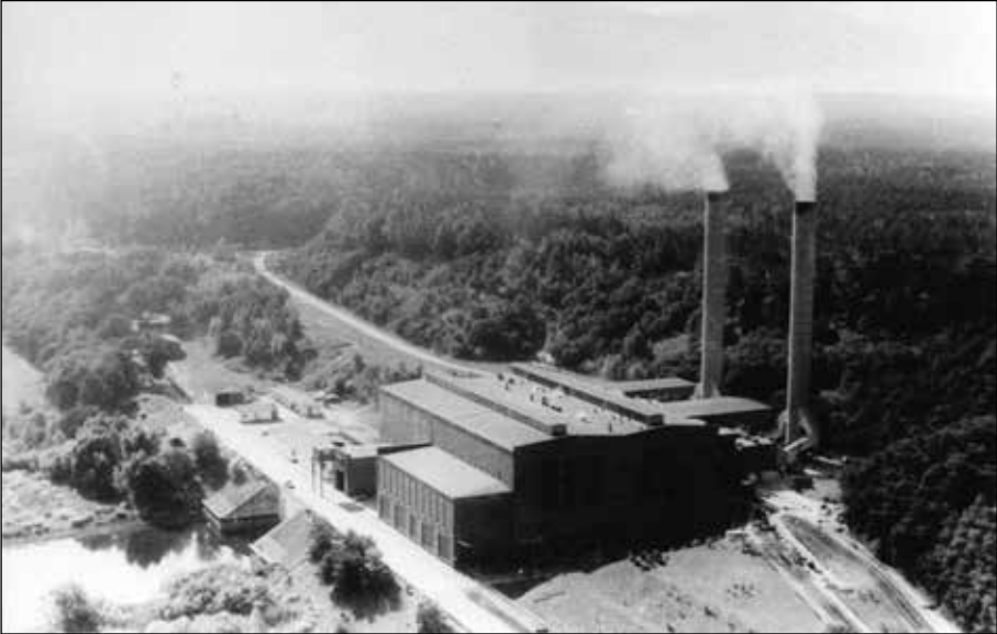
Kraftwerk Ost-Hannover (Foto: Dokumentenhaus Neuengamme)
