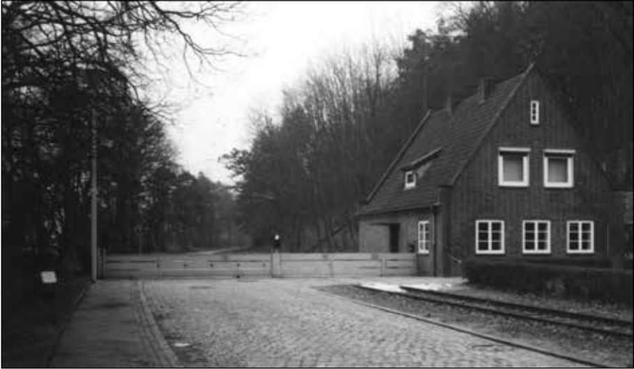
Toreingang zum HEW-Kraftwerk Alt Garge (Foto: Hopp)
